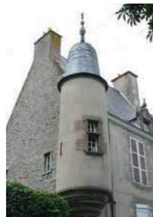
La tourelle d'angle de l'hôtel Chappedelaine sur la place de Cheverus.
